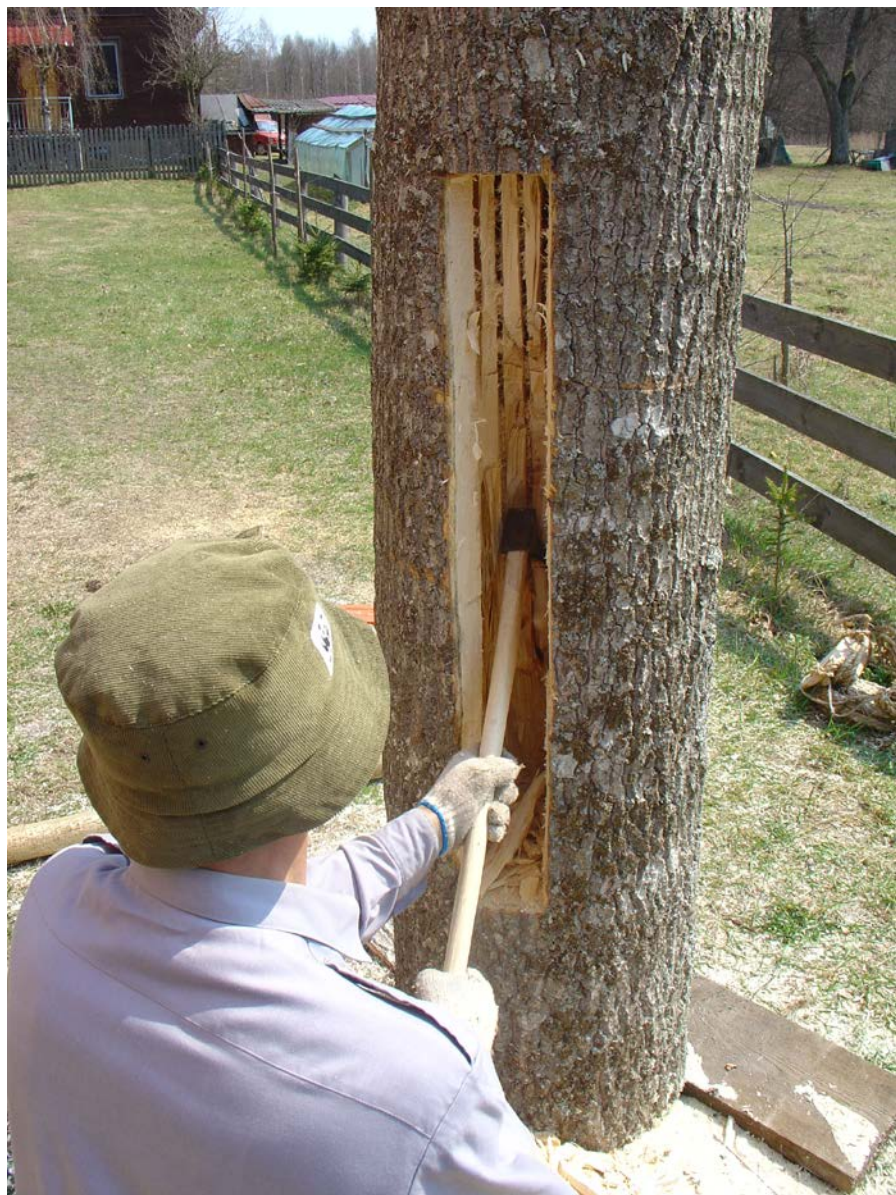
Zdj. nr 10 Praca cieślą. Widoczne ślady nacięć pilarką po wybraniu dużej części drewna pieszną. Autor: Sieńko A.
